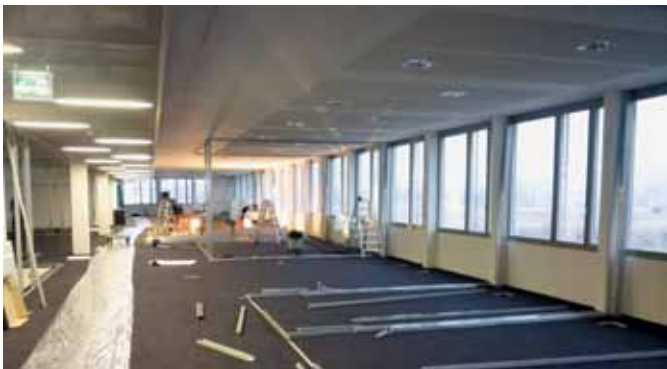
Der Konferenzbereich mit Bewirtungszone entstand aus einem Büro-Regelgeschoss. Hier Aufnahmen von Januar (Bild oben) und April 2010 (Bild ganz unten). Auch die Montage der Trennwände (Bilder in der Mitte) in den Büroetagen verlief zügig.
